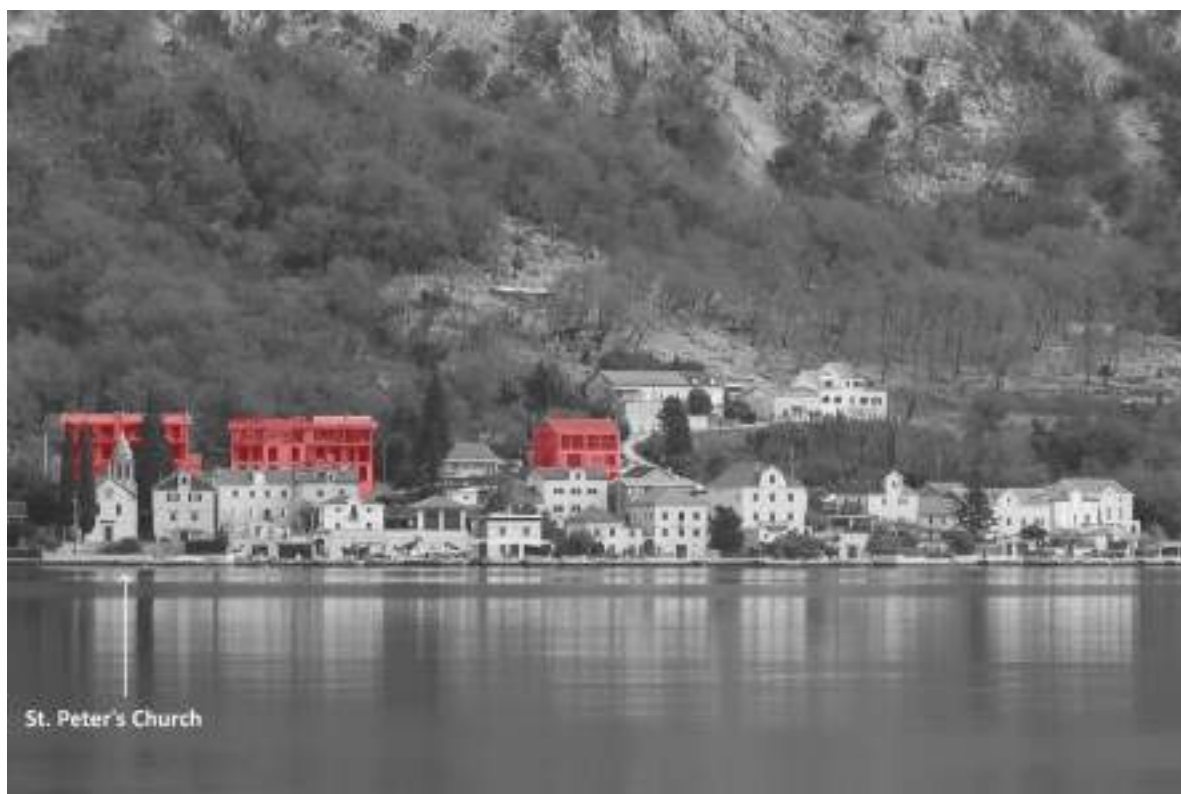
Nove konstrukcije u istorijskom naselju Ljuta, januar 2025.
