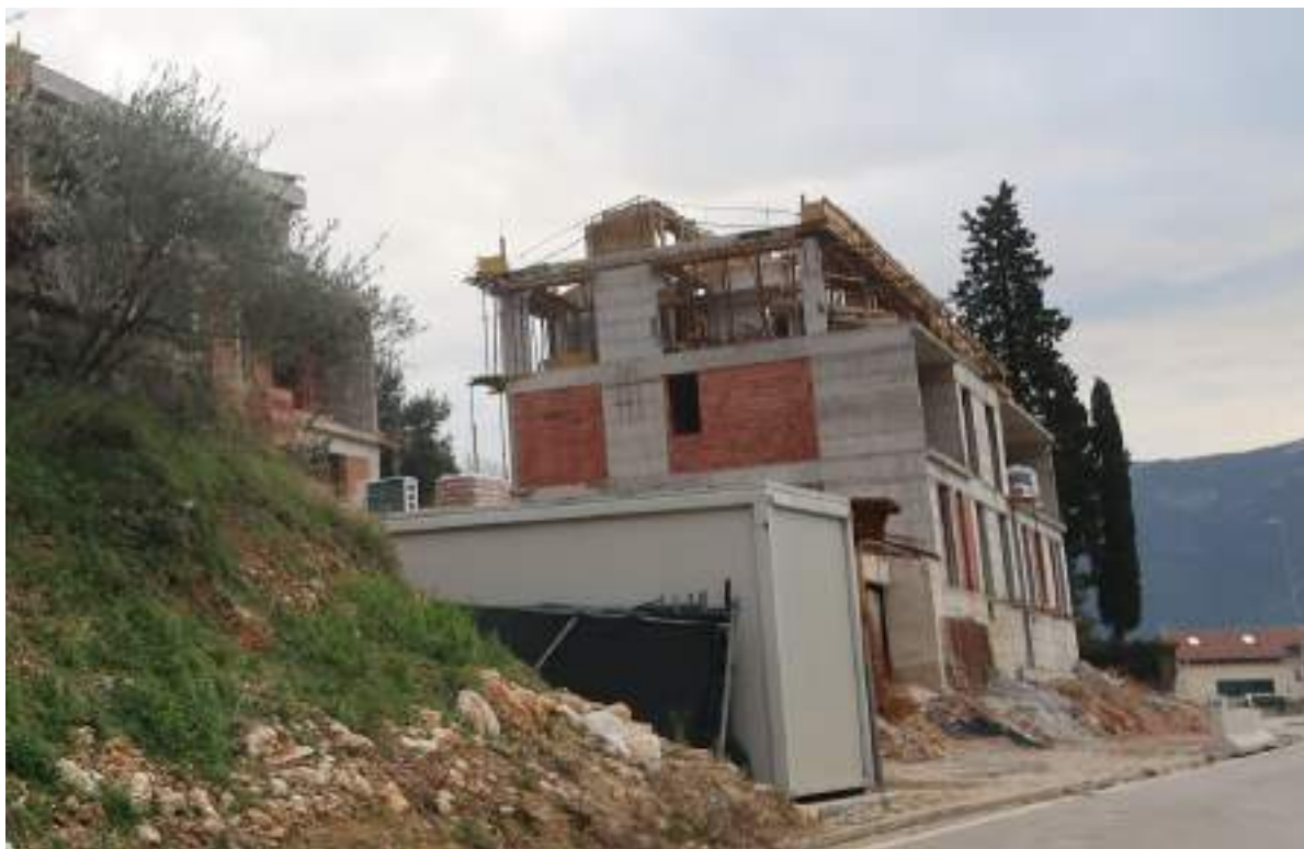
Primjer objekata koji su trenutno u izgradnji na Ljutoj, klasifikovanih kao Po+P+1+Ps (podrum, prizemlje, prvi sprat i „povučena etaža“).
