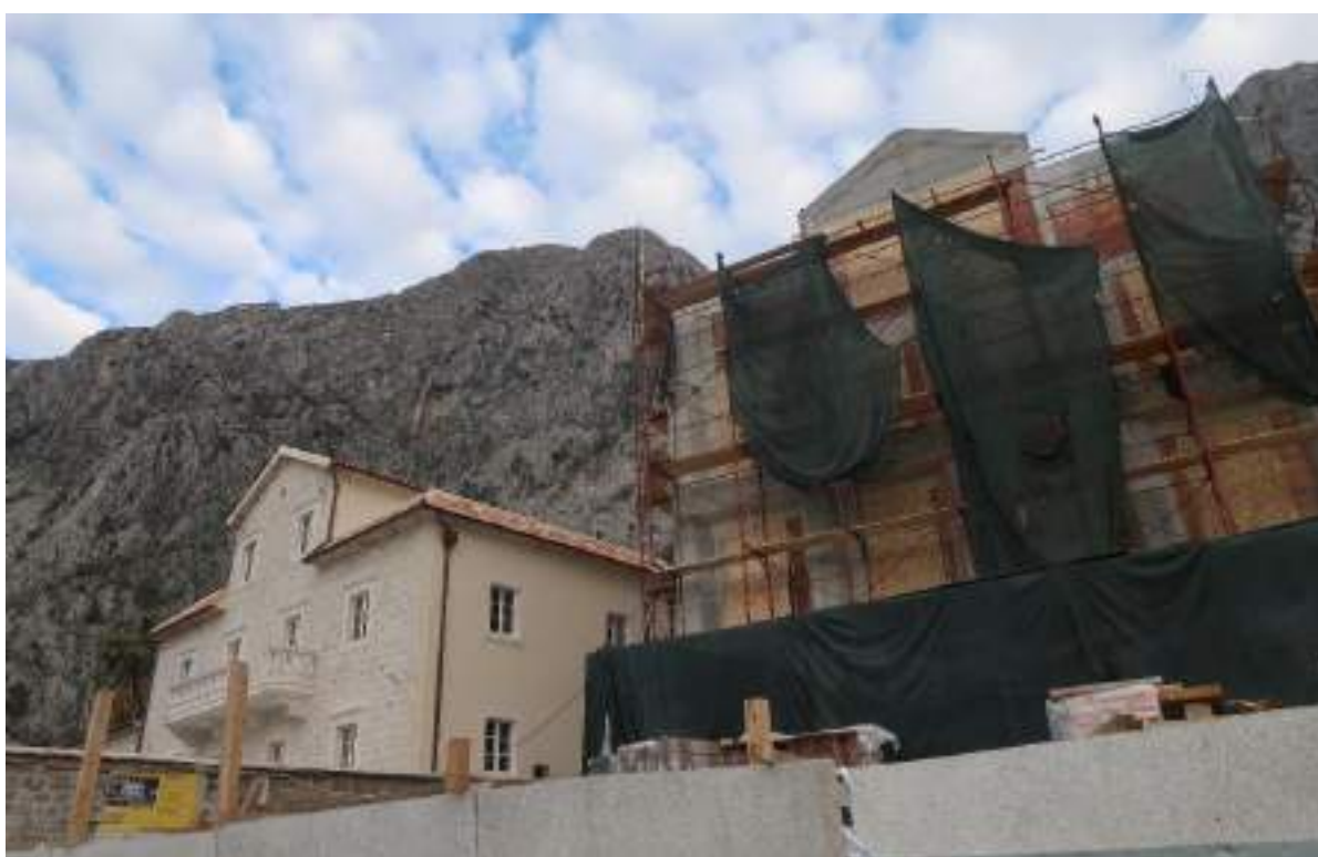
Novi objekat na Ljutoj, interpoliran u niz tradicionalnih objekata, januar 2025.
