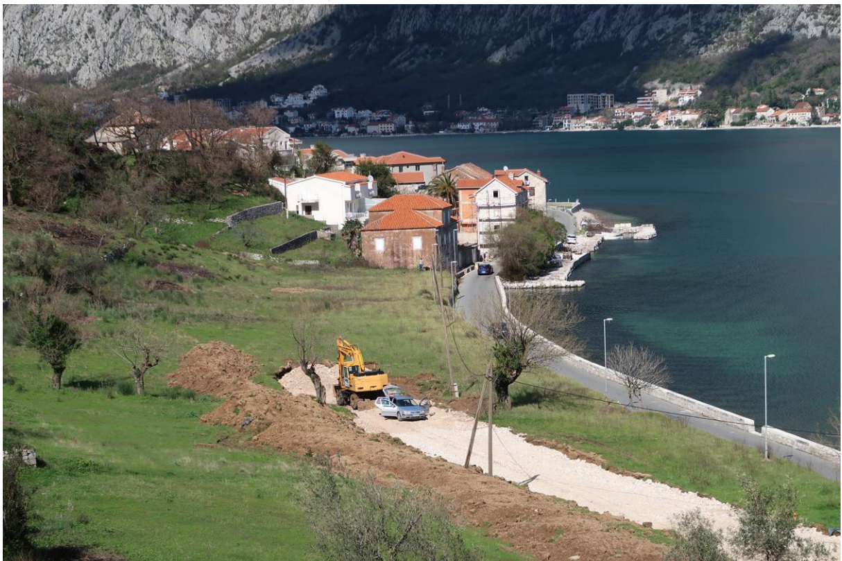
Radovi na izmještanju kablova, april 2018.
