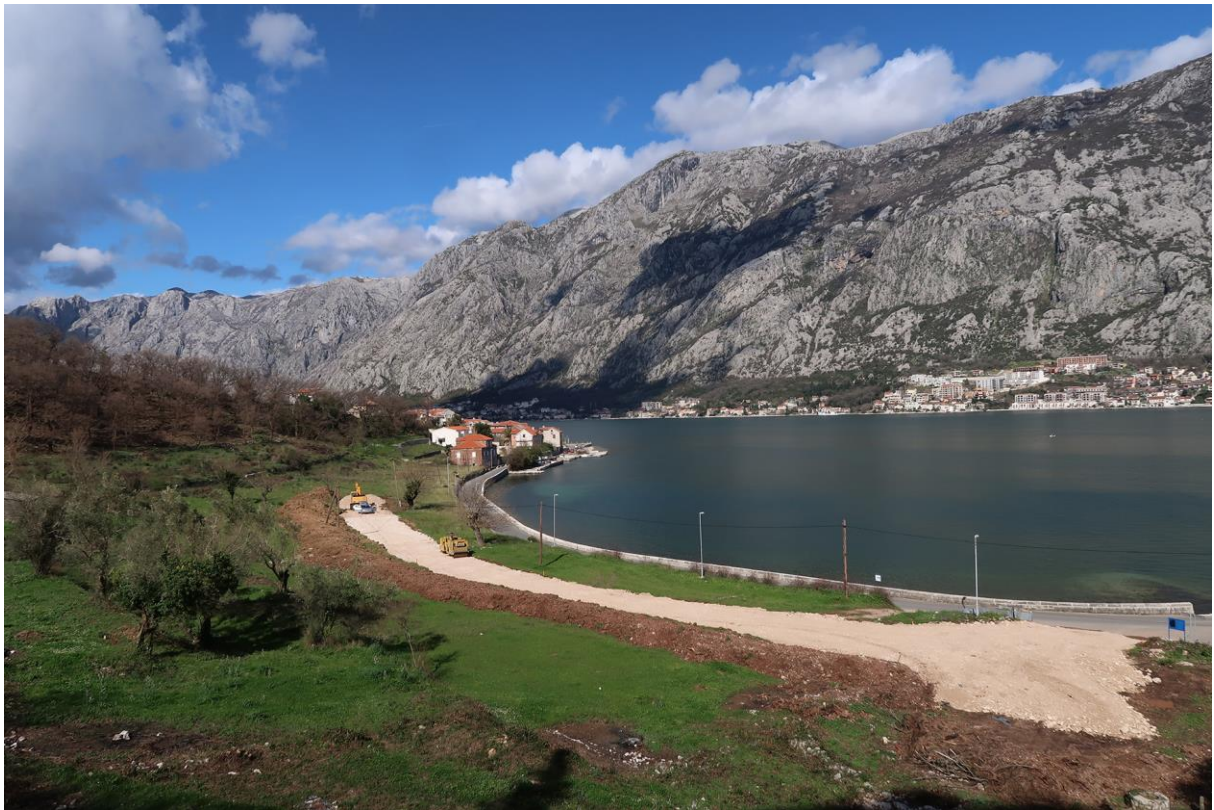
Radovi na izmještanju kablova, april 2018.
